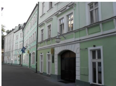
Dům U Zlaté harfy v Lázeňské ulici v Teplících, kde byl Beethoven ubytován
